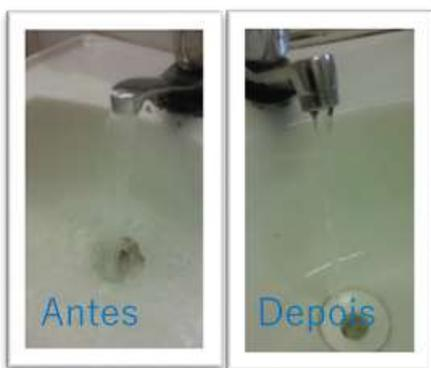
Figura 6 - Instalação de aeradores nas torneiras dos banheiros
