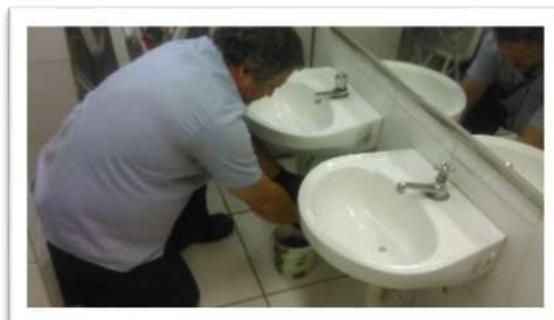
Figura 7 - Instalação de aeradores nas torneiras
